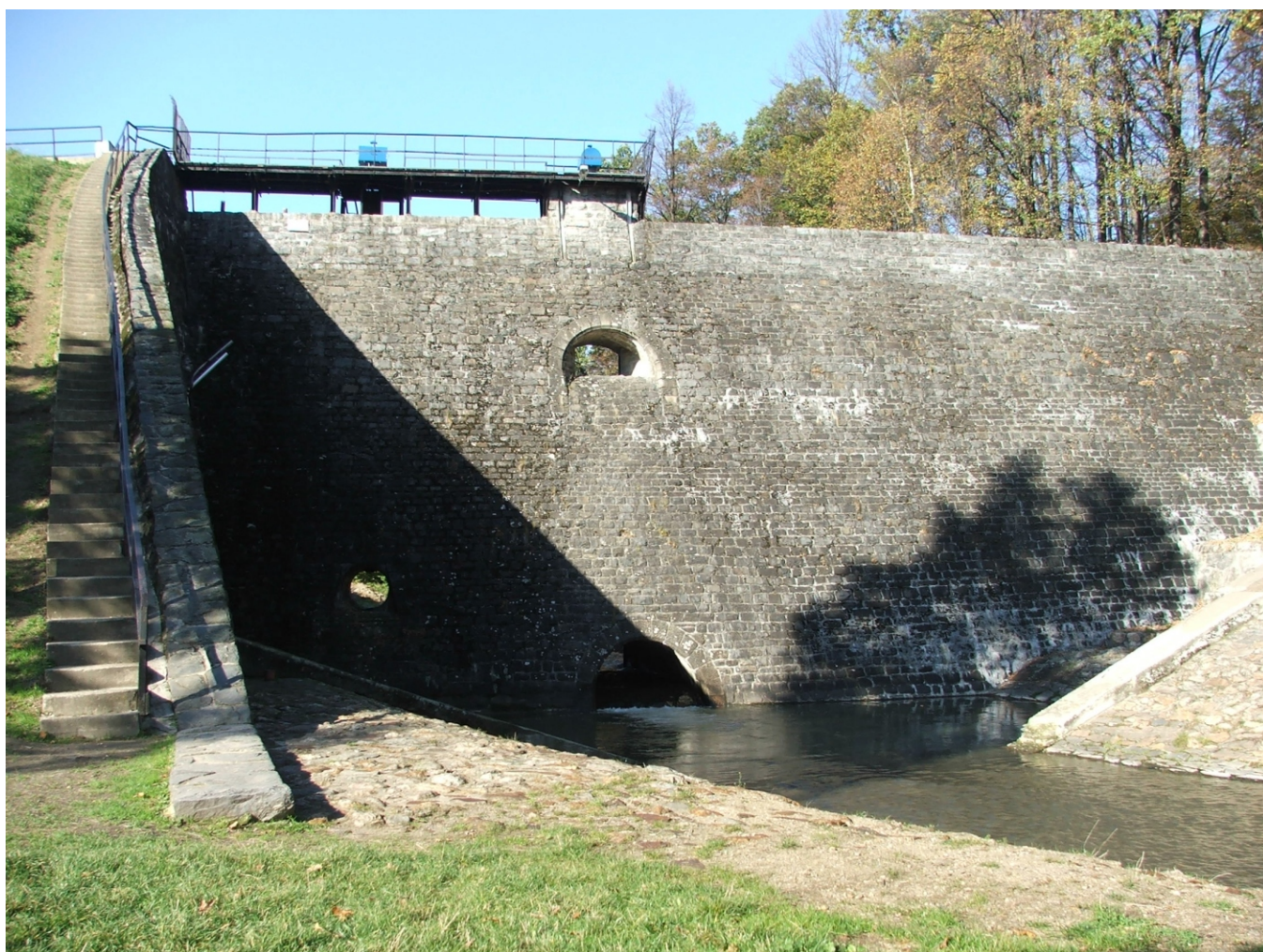
Jedinečná technická památka v Jarnoltówku - protipovodňová hráz, vybudovaná v roce 1909 díky finanční pomoci císařovny Augusty Viktorie, aby chránila tehdejší Arnoldsdorf i okolí. Hráz je vysoká přes 15 m a v roce 1997 zachránila Jarnoltówek i Pokrzywnou od zkázy, kdy velké vodě Zlatého potoka chybělo 50 cm k překonání hráze !
